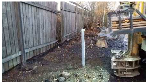
Valokuva 54. Piste VAH44 kohdalle asennettu pohjavesiputki PVP1_2019.
