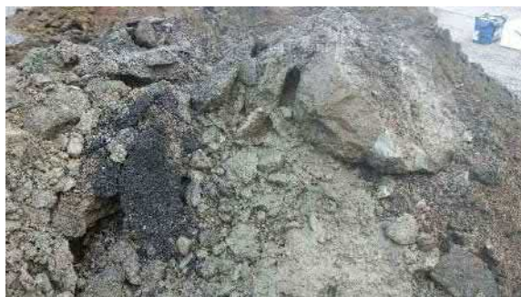
Valokuva 16. Koekuopassa VAH11 havaittiin paksusti asfaltitäyttöä.
